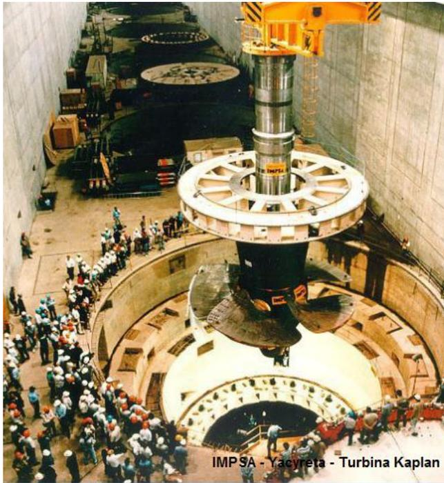
Figura 15 – 3. Imagen de una de las turbinas Kaplan, desarrolladas por IMPSA para la represa de Yaciretá.
